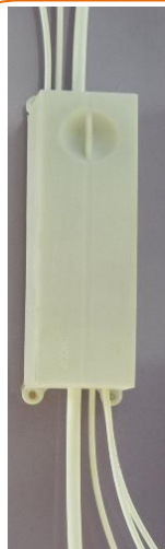
Exemple 1 : Be-box 12 installé dans une gaine technique
